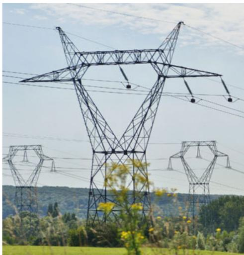
Les pylônes de la ligne à 225 000 volts existante peuvent accueillir soit deux circuits à 225 000 volts, soit un circuit à 400 000 volts. Ils sont actuellement équipés d'un seul circuit à 225 000 volts.
