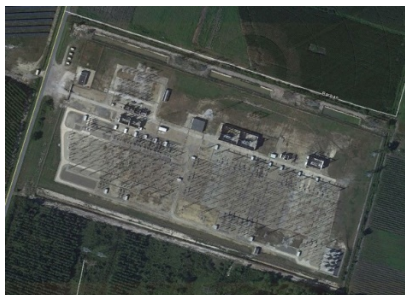
Vue aérienne du poste de Saucats
